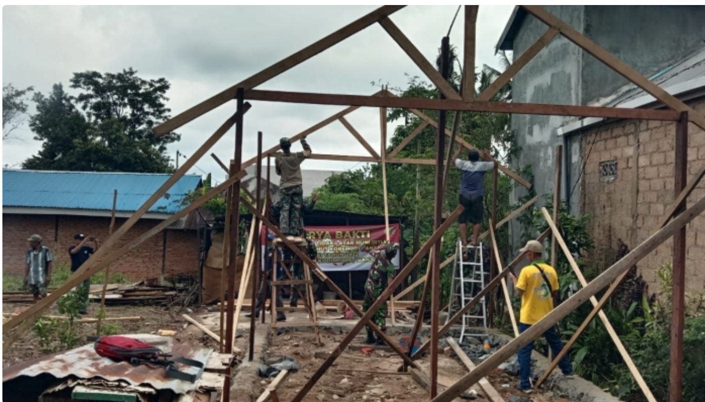
Setelah Dirobohkan " Kini Rumah Nursiah Dipasang Pondasi Dan Kuda - Kuda Rangka Rumah
